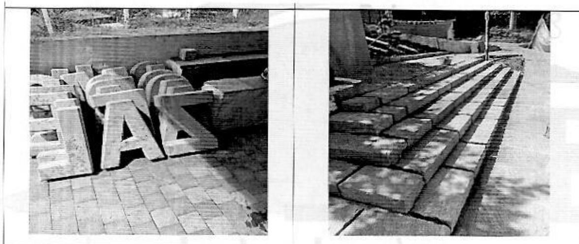
Se realiza la instalación de piedra barichara (losa y gradas ) sentadas en concreto para garantizar su estabilidad y chapa de .15cm para mejorar los bordillos de las materas en concreto
