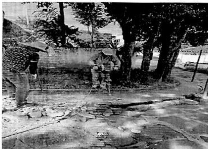
Se realizaron las actividades de demolición de andenes perimetrales y gradería y pisos en concreto
